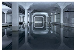
Hardhof Lengg II (2008) Seewasserwerk Lengg, Trink-wasser-Aufbereitungsbecken 7/7 80 x 120 cm Last 10'000
