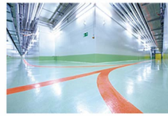
Zwilag III (2008) Zwischenlager, Verbindungsgang mit Leitsystem für Roboterfahr-zeug, 3/7 80x120 cm 2'400
