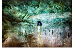
Ferrera II (2011) Wasserkraftwerk Ferrera, Wasserschloss 2/7 80 x 120 cm 2'400
