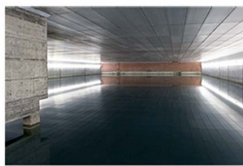
Hardhof Lengg I (2008) Seewasserwerk Lengg, Trink-wasser-Aufbereitungsbecken 1/7 80 x 120 cm 2'400
