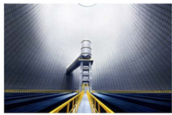
Trianel I (2011) Kohlenkraftwerk, Kühlturm 3/7 80 x 120 cm 2'400
