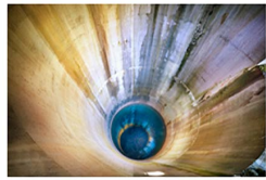
Ferrera III (2011) Wasserkraftwerk Ferrera, En- lastungsstollen 3/7 80 x 120 cm 2'400
