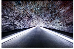
Ferrera I (2011) Wasserkraftwerk Ferrera, Zugasstollen 7/7 150 x 225 cm Last 12'000
